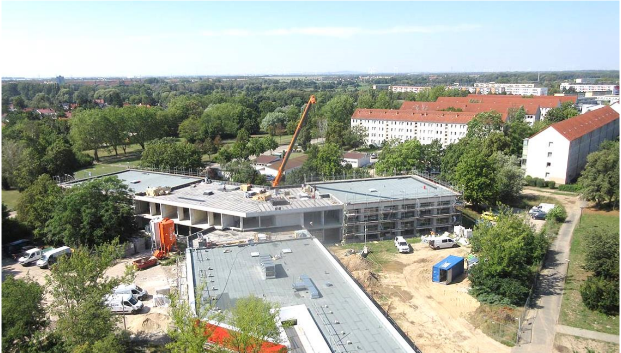
SARA Seniorenresidenz Haus III (chantier actuel) – Bitterfeld-Wolfen
