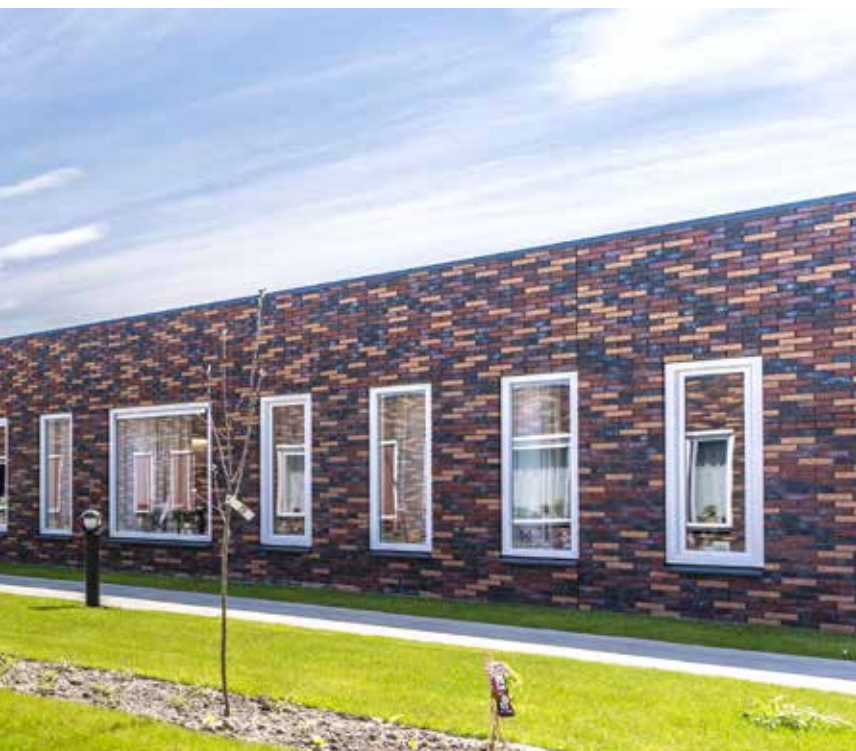
VERPLEEGCENTRUM SCHEEMDA • SCHEEMDA, NL
