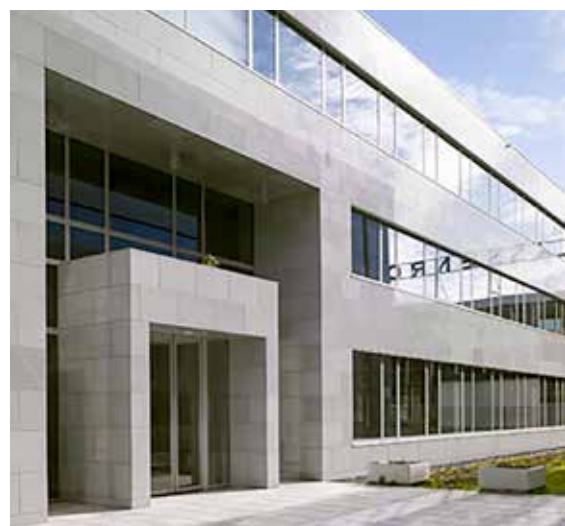
Immeuble de bureaux West End - Grand-Bigard (BE)
