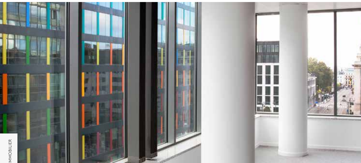
Immeuble de bureaux Loi 34 - Bruxelles (BE)
