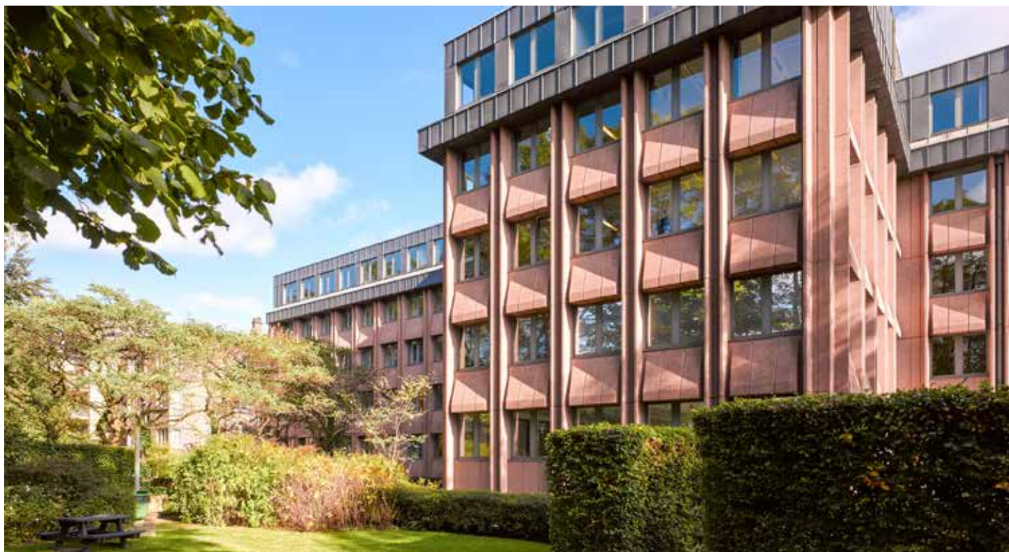
Immeuble de bureaux Souverain 280 - Bruxelles (BE)
